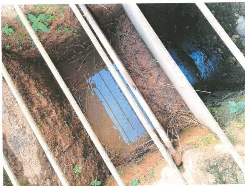
Foto 10 – Sistema de escoamento obstruído.
