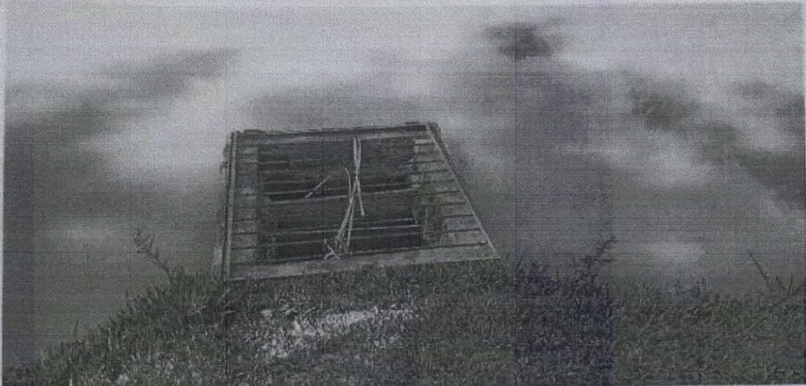
FOTO 10 – FOTO TIRADA DO LADRÃO DO LAGO DENTRO DO PARK HOTEL, APÓS O ASSOREAMENTO ESSE LADRÃO FOI ABSTRUIDO COM TERRA PROVENIENTE DO ASSOREAMENTO CAUSANDO TRANSBORDAMENTO DO LAGO E SÉRIOS TRANSTORNOS PARA OS HOSPEDES DO PARK HOTEL.
