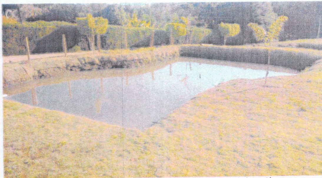
Imagem 4 – Aqui podemos notar os dois lagos sendo que o de baixo está menos aparente, porém observamos os taludes e as margens dos dois lagos gramadas.
