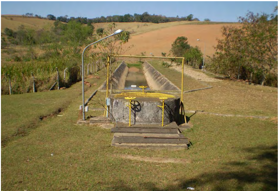
Captação Rio das Pedras (Canal) ETA cidade.
