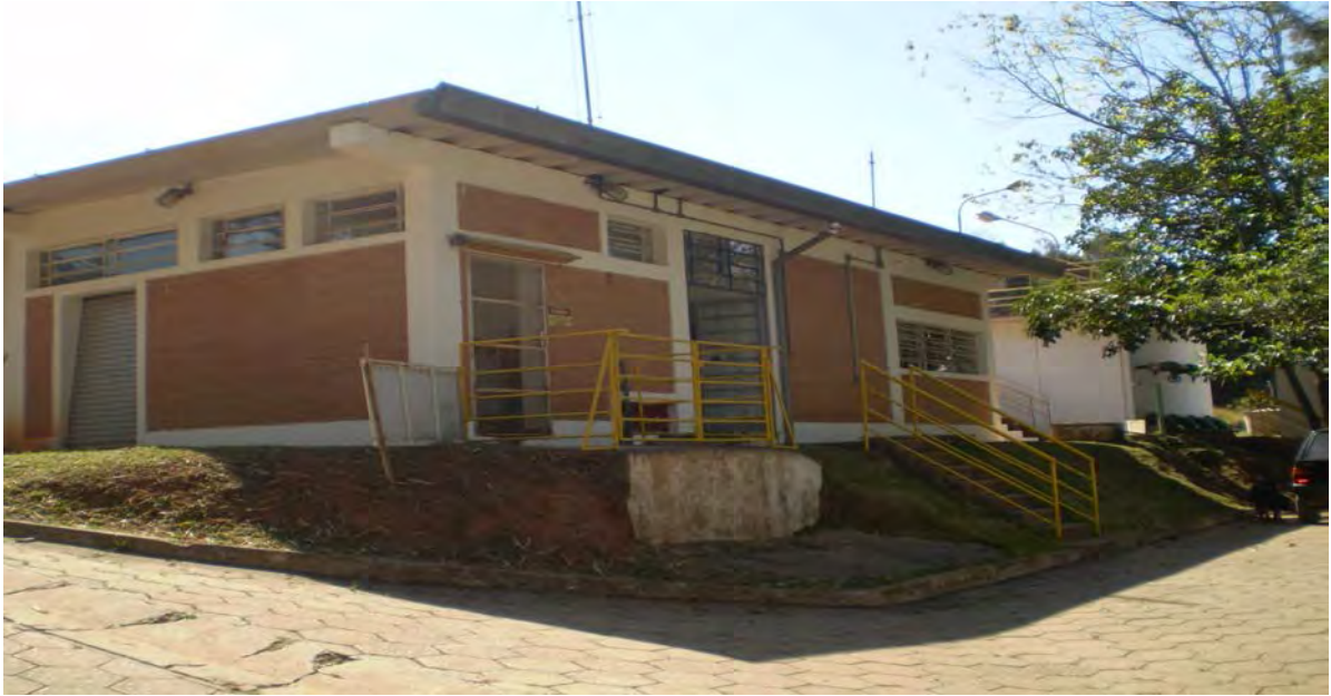
Vista externa da ETA (Bairro Rosa Mendes) ETA cidade.
