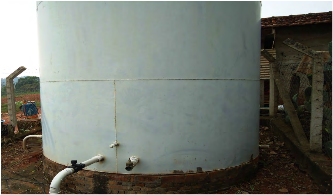
Reservatório Bairro Aparecidinha
