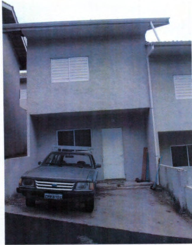
CASA 81 BLOCO E
