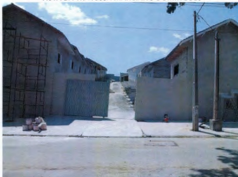
VISTA DA TRAVESSA MARCIANO DOMINGUES
