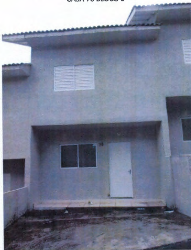
CASA 76 BLOCO E
