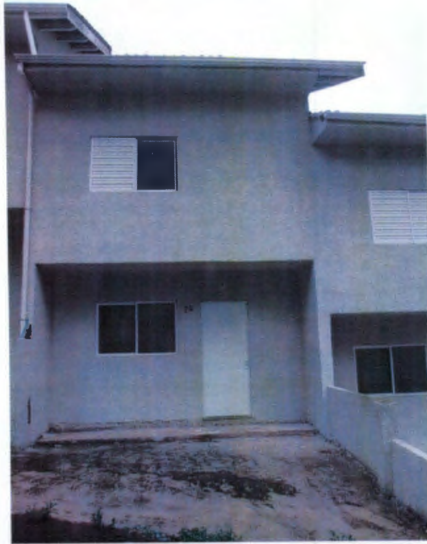
CASA 79 BLOCO E
