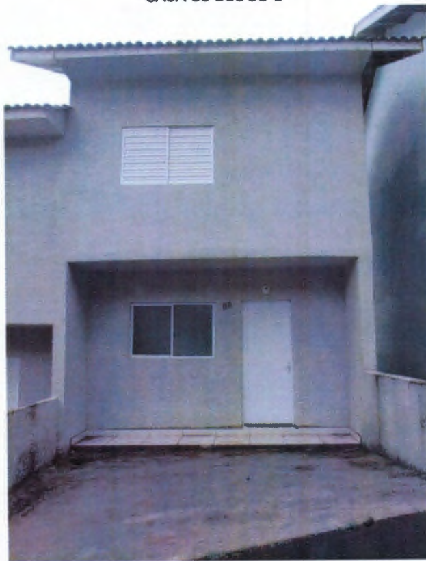
CASA 80 BLOCO E
