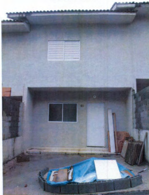
CASA 68 BLOCO E
