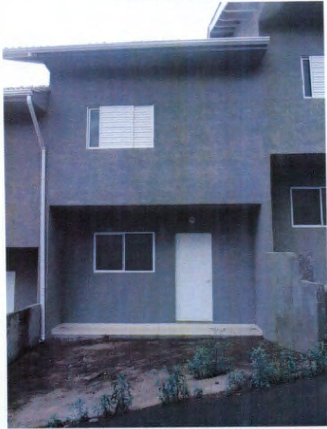
CASA 30 BLOCO B
