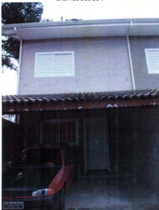
CASA 82 BLOCO F
