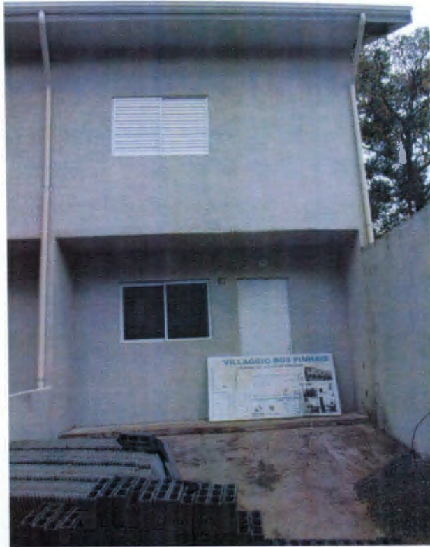
CASA 67 BLOCO E
