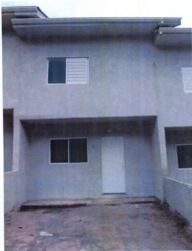
CASA 73 BLOCO E
