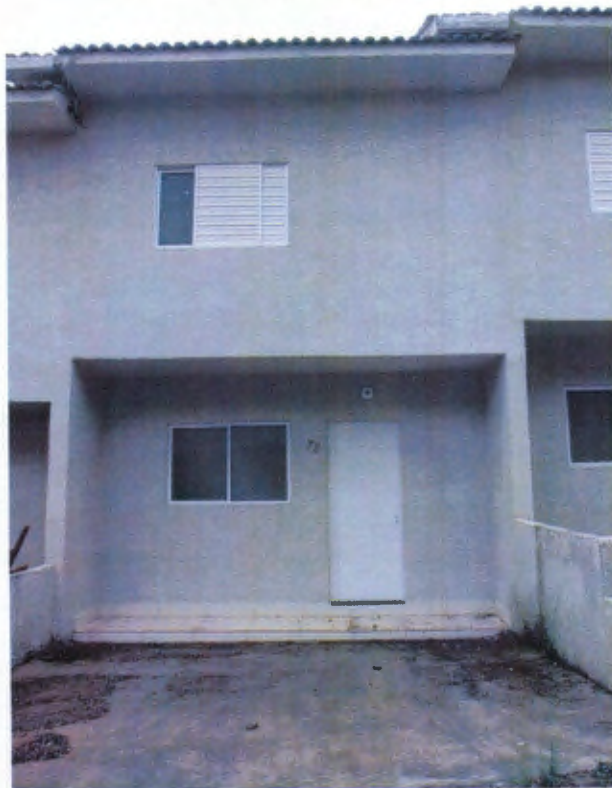
CASA 72 BLOCO E
