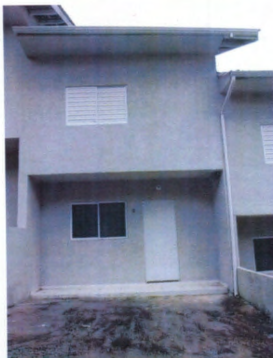
CASA 77 BLOCO E
