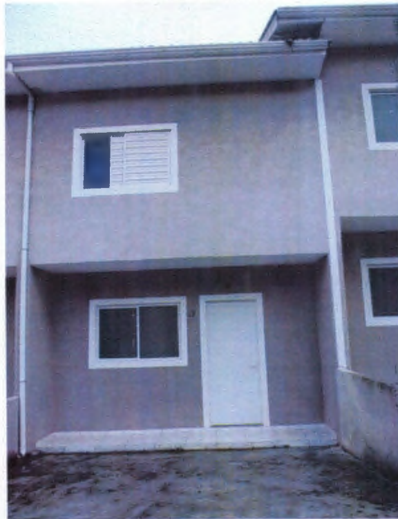
CASA 87 BLOCO F
