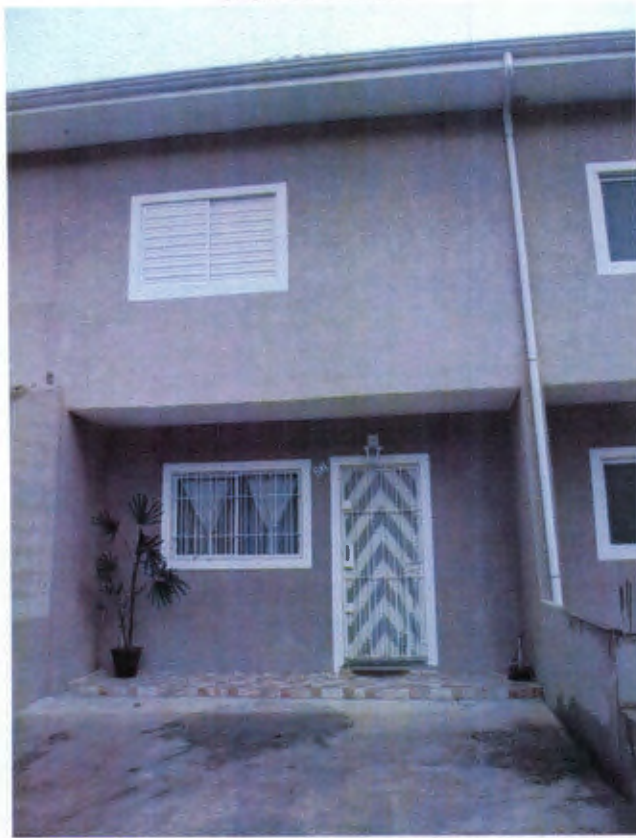
CASA 86 BLOCO F
