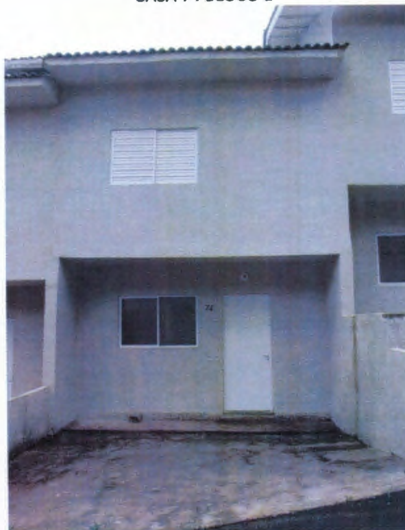
CASA 74 BLOCO E
