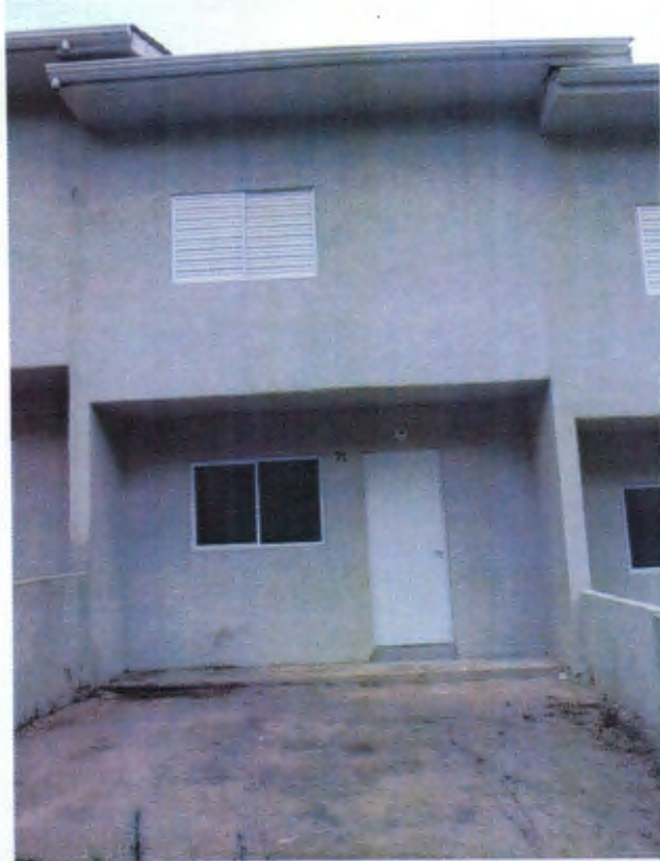
CASA 71 BLOCO E
