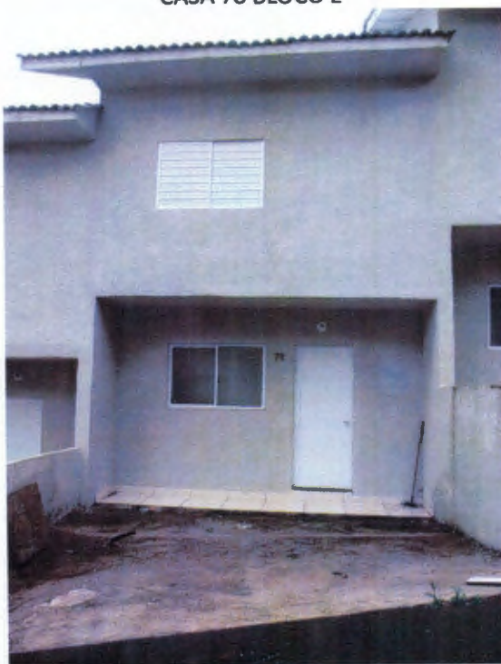
CASA 78 BLOCO E
