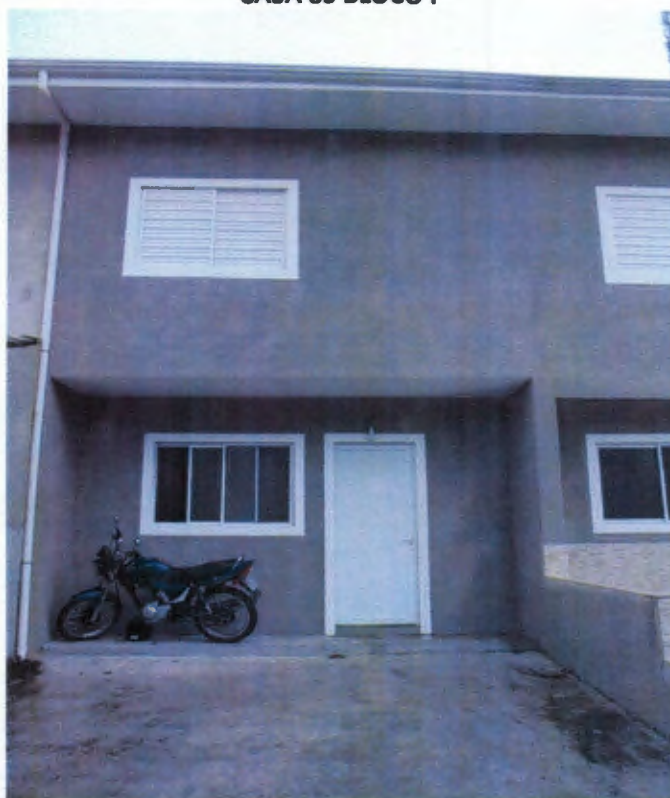
CASA 83 BLOCO F
