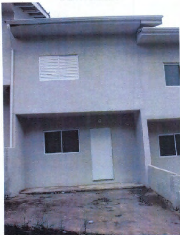
CASA 75 BLOCO E
